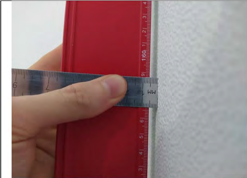
Фото №10. Измерения уровня стен в кухне.
