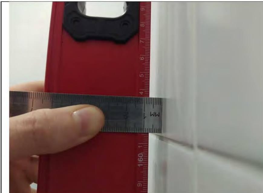
Фото №13. Измерения уровня стен в санузле.
