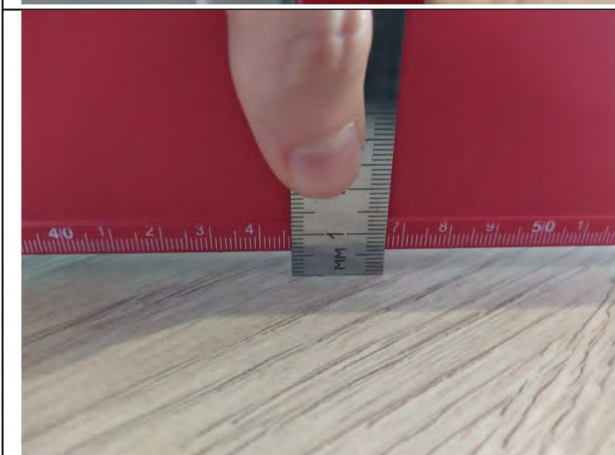
Фото №15. Измерения уровня напольного покрытия в гостиной.
