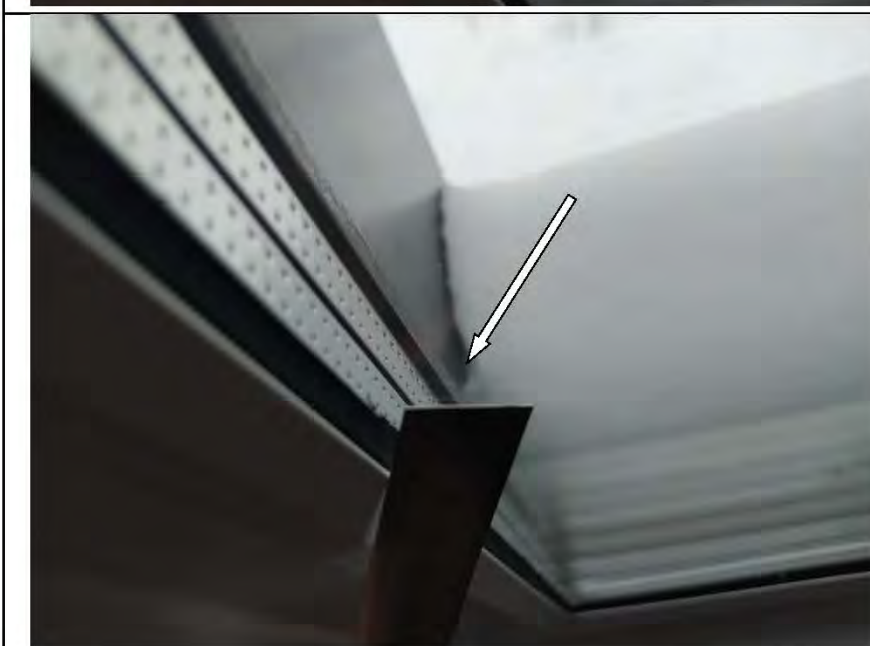
Фото №30. На стеклопакете оконного блока ПВХ в гостиной имеется дефект (царапина).
