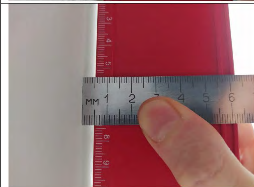
Фото №12. Измерения уровня стен на балконе.
