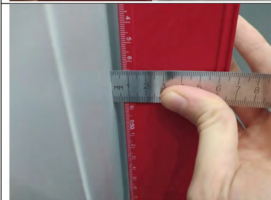
Фото №14. Измерения уровня стен в ванной комнате.
